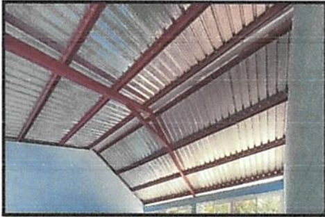
Foto 3: Costaneras y cambio de techo
