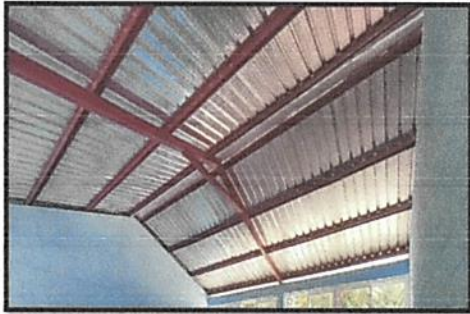
Foto 3: Costaneras y cambio de techo
