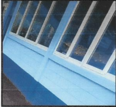
Foto1: Instalación de Ventanas tipo pvc
