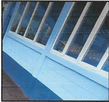
Foto1: Instalación de Ventanas tipo pvc
